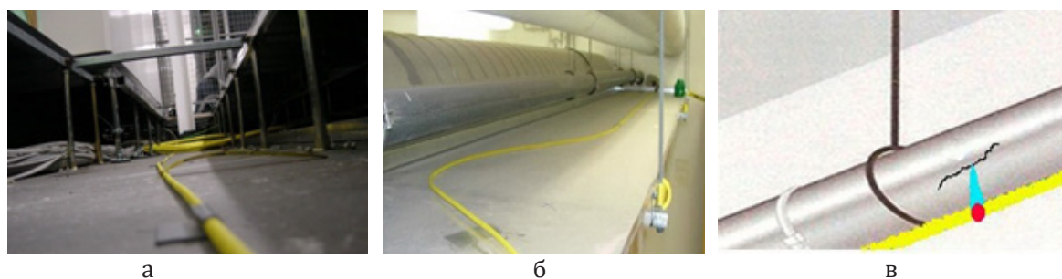
Рис. 2. Примеры размещения гидросенсорного кабеля: традиционного – на полу (а) и в лотке под трубопроводом (б); СКС – на поверхности трубопровода снизу (в).
